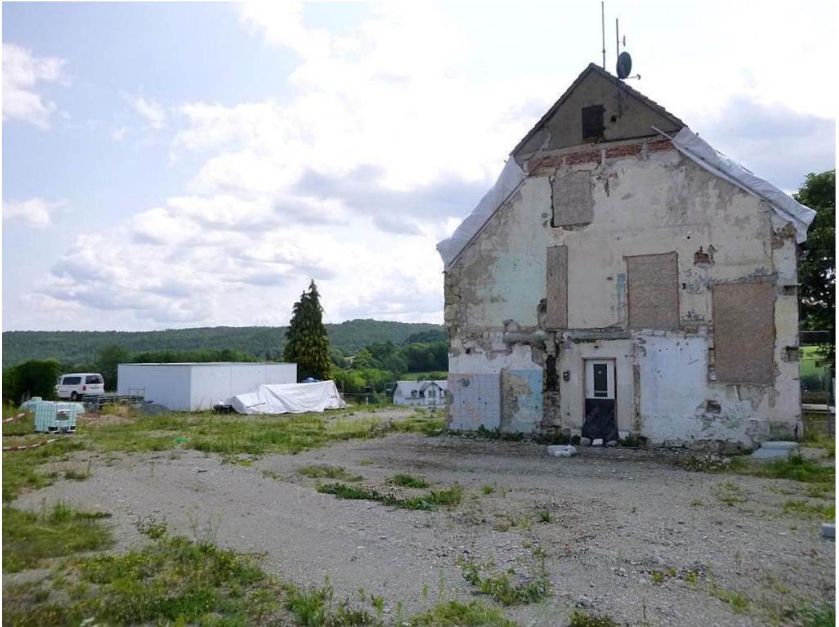
Bild 3: Blick nach Südosten auf das Bestandsgebäude.
