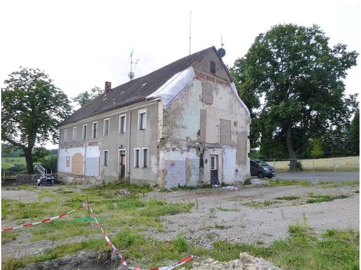
Bild 2: Blick nach Süden auf das Bestandsgebäude.
